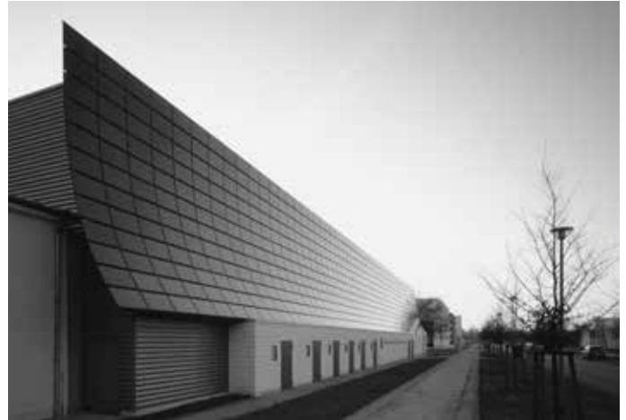
Impianto fotovoltaico per enti pubblici
